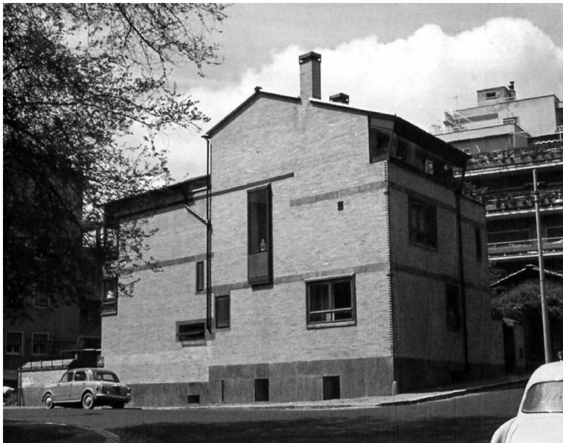
Veduta da via dei Monti Parioli di Casale Gomez ristrutturato. Roma, Accademia Nazionale di San Luca, Archivio del Moderno e del Contemporaneo, Fondo Federico Gorio. Sotto: Veduta da via dei Monti Parioli di Casale Gomez prima dell'intervento. Roma, Accademia Nazionale di San Luca, Archivio del Moderno e del Contemporaneo, Fondo Federico Gorio
